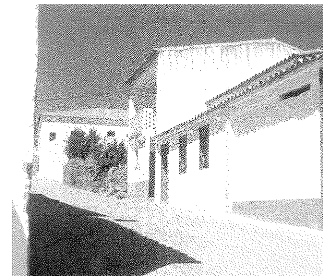
Club del Pensionista de Los Morenos. En fase de Ejecución
